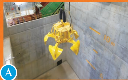
A 粗大・破碎ごみピット 粗大ごみ、破碎ごみを一時貯留するためのピットです。
